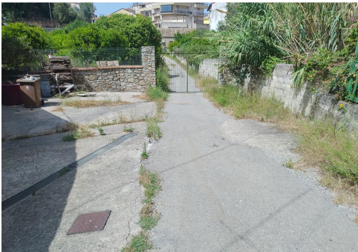
Foto 33. In corrispondenza dell'accesso all'agrumeto il pozzetto della linea comunale di adduzione idrica dell'acqua potabile
