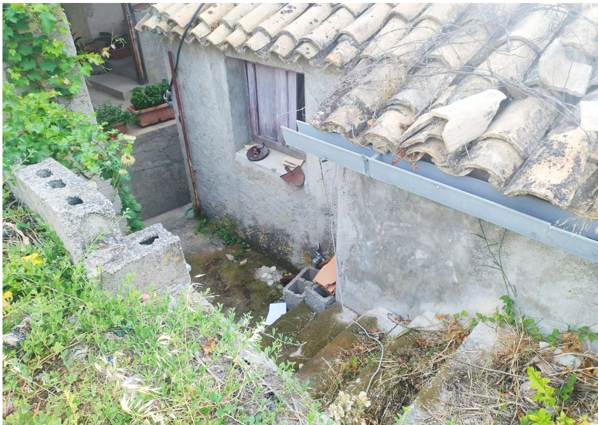
Foto 29. La scala di accesso all'ex vigna ricavata nello spazio fra i muri di contenimento e del fabbricato
