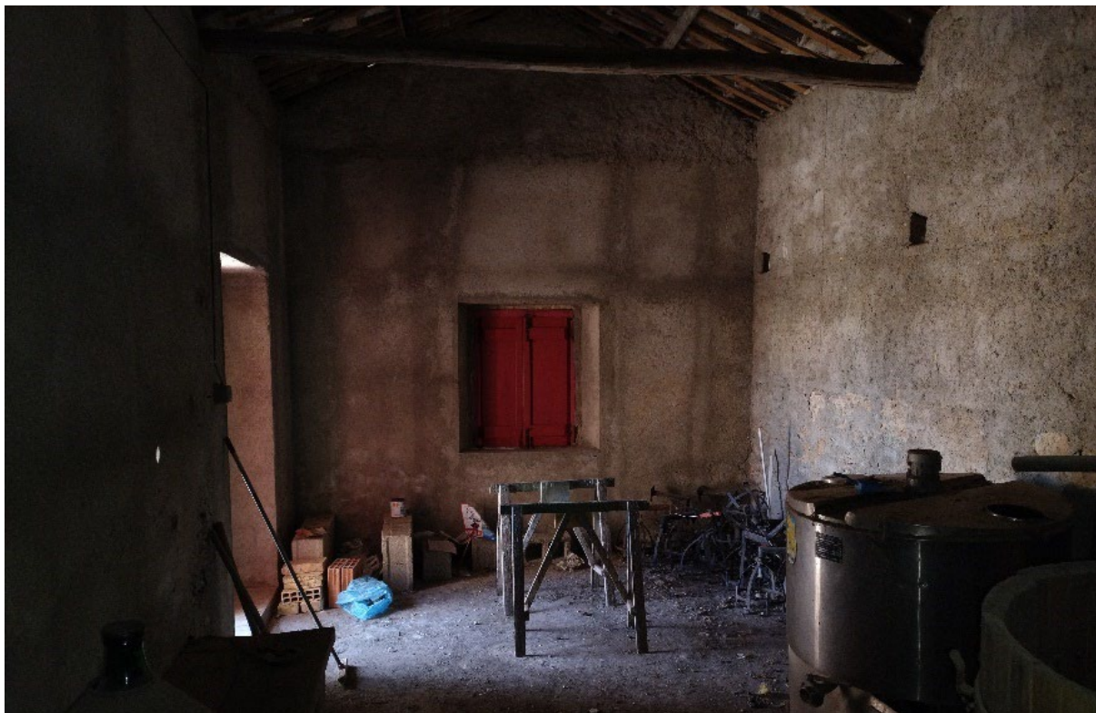
Foto 31. Sala ingresso Reception. è necessario un intervento di manutenzione straordinaria per adeguare l'edificio alle nuove funzioni. Non si interviene sugli elementi strutturali portanti.
